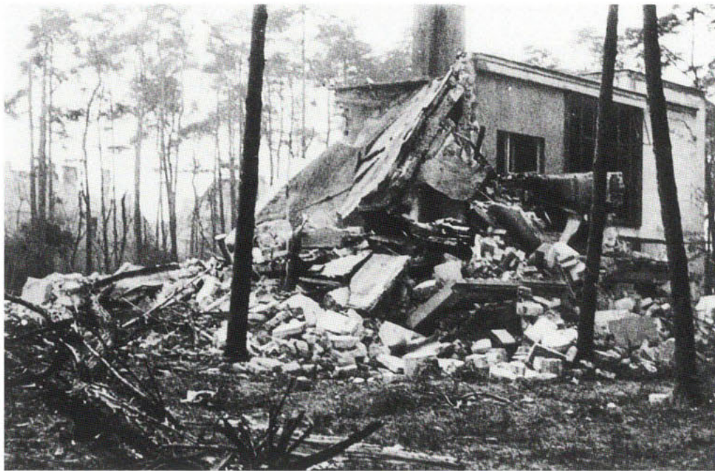
2. Dessau, das zerstörte Doppelhaus Moholy-Nagy (links) und Feininger (rechts) nach der Bombardierung am 7. März 1945
