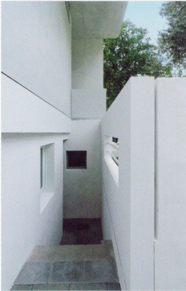
6. Dessau, Haus Gropius, Abgang zum bauzeitlich erhaltenen Sockelgeschoss, 2014
