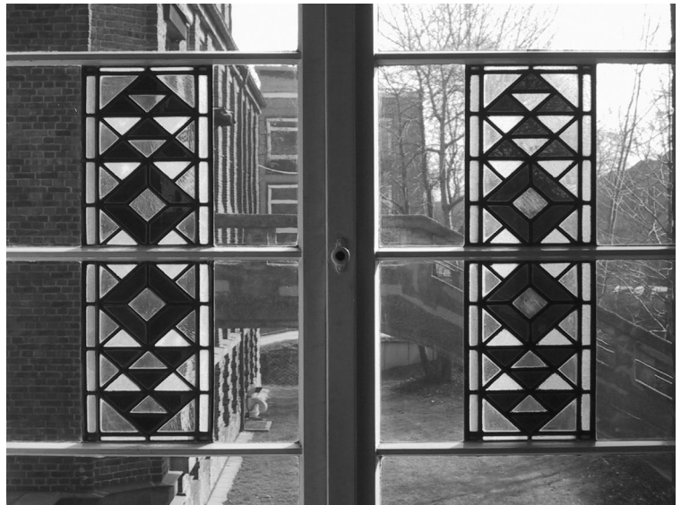
Abb. 7: Fenster (Raum TR 05)
