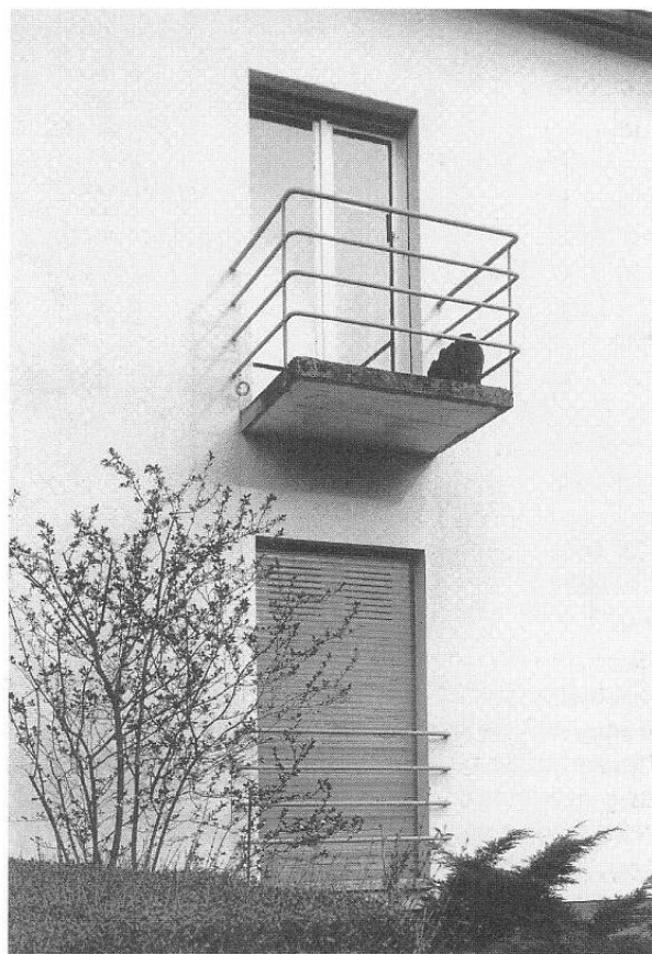
12 Fassadendetail der Dammerstock-Bebauung 1934/35: Balkon nach dem Vorbild des Bauhausgebäudes in Dessau
