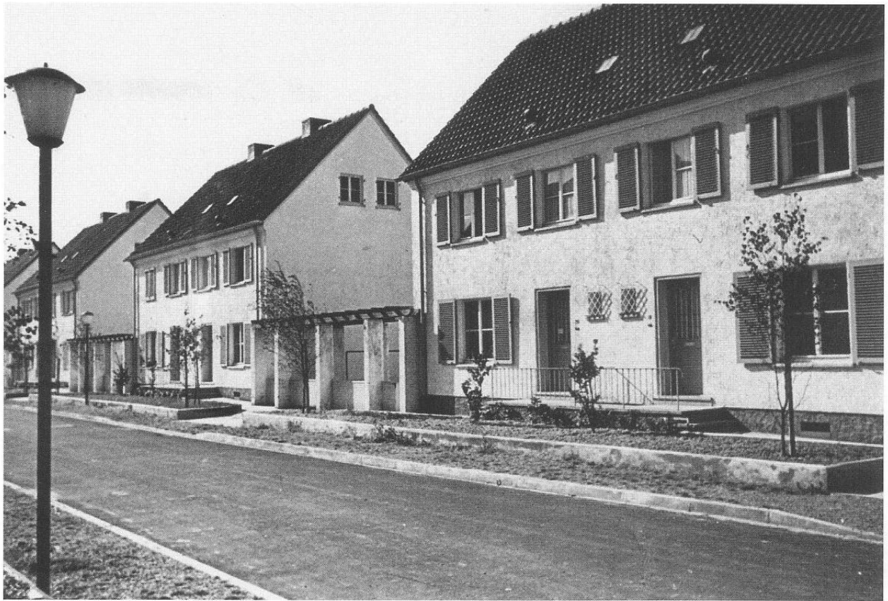
18 Gagfah-Häuser, Mainzer Straße, 1937
