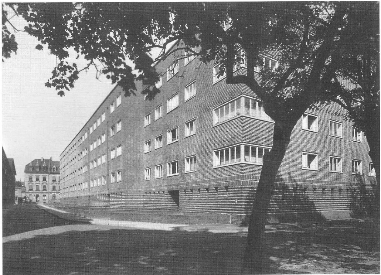
10 Hans Becker, Wohnblock der Eisenbahner-Baugenossenschaft, Häusserstraße / Stuttgarter Straße, ab 1929
