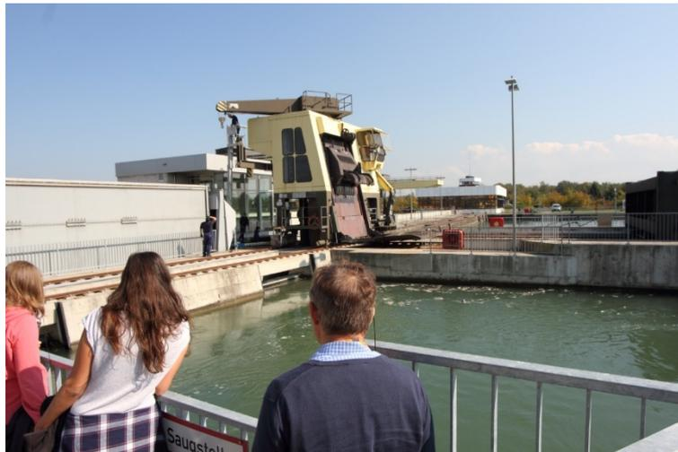
Die Staustufe Iffezheim mit dem dazugehörigen Kraftwerk, einem Wehr, einer Doppelschleuse und seit 2000 auch einem Fischpass gehört zu einem der zehn Wasserkraftwerke, welche zwischen Basel und Karlsruhe entlang des Oberrheins rund 9 Mrd. kWh regenerativen Strom produzieren.
