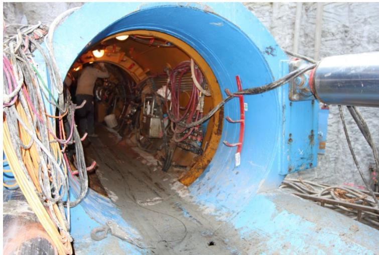
Gegenüber der offenen Grabenbauweise war der Rohrvortrieb aus folgenden Gründen sinnvoll: In 8 m Tiefe war der Rohrvortrieb wirtschaftlicher. Leitungen, die zwischen Kanal und Geländeoberkante liegen, müssten nicht freigelegt werden und Grundstücke bleiben unbeeinträchtigt. Außerdem stellte der Rohrvortrieb mit den zwei Start- und Zielgruben einen geringeren Eingriff in die Natur dar.
