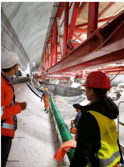
Abbildung 6: Sohlschalwagen zur Auffüllung mit Füllbeton
