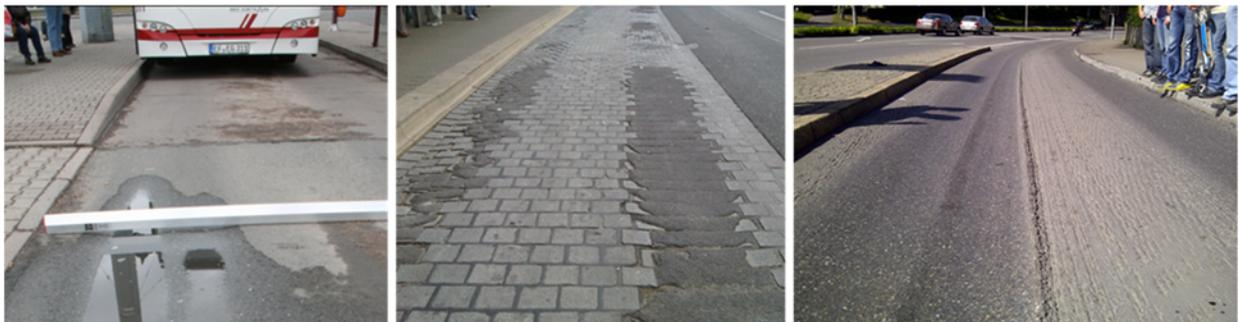
Abbildung 2: Schäden an Verkehrsflächen infolge spurgeführtem Verkehr (Quelle: eigene)
