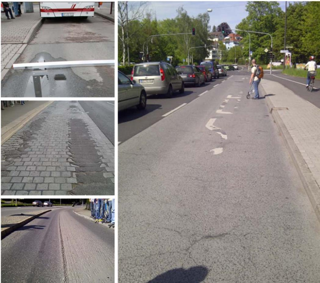
**Bild 1: Typische Schäden auf Busspuren und Bushaltestellen (Großmann et al., 2015)**
