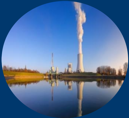
7 Standorte mit Steinkohlekraftwerken in Deutschland
