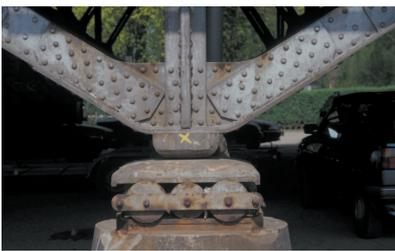
Abb. 9: Gleitlager der Freybrücke
