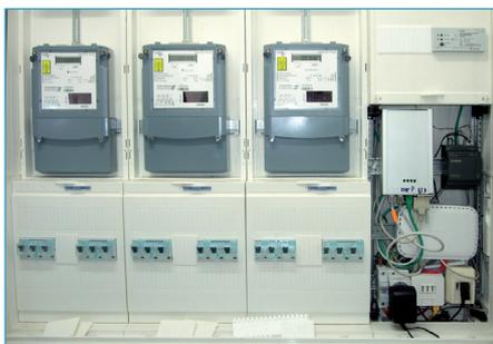
ABB. 5: ZÄHLERKASTEN DES TESTNETZES MIT ZGS (HSG, DSL-ROUTER UND MONITOR-RECHNER)
