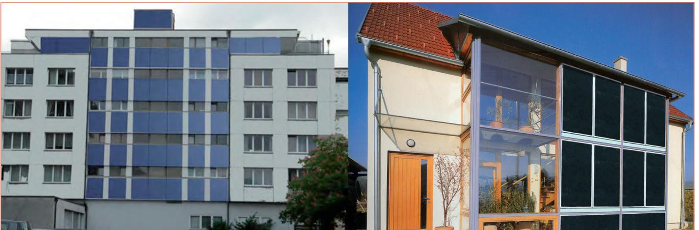
ABB. 6: EINBINDUNG IN DIE FASSADE EINES MEHRFAMILIENHAUSES MIT MINIMIERTER KOLLEKTORFLÄCHE FÜR EINEN PASSIVHAUSSTANDARD, RECHTS: EINBINDUNG IN DEN WINTERGARTEN EINES EINFAMILIENHAUSES
