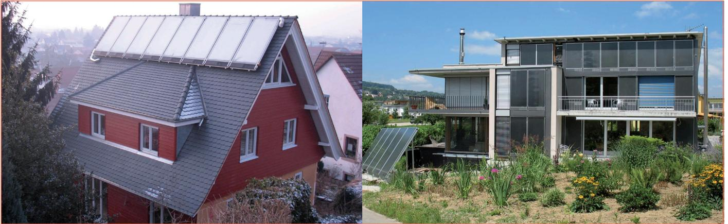
ABB. 1: ALTBAU MIT AUFDACHMONTAGE UND DOPPELHAUSNEUBAU MIT FASSADENINTEGRATION
