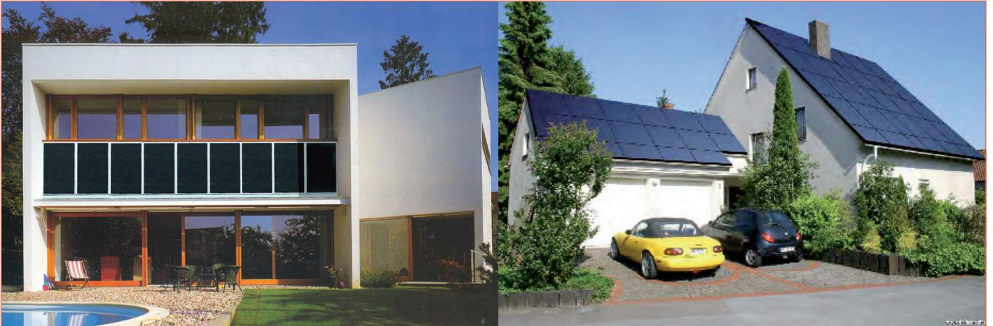
ABB. 5: LINKS: EINBINDUNG IN DEN BRÜSTUNGSBEREICH, RECHTS: EINFAMILIENHAUS MIT SOLAREN DACHFLÄCHEN AUS SONDERFORMATEN. DER NEIGUNGSWINKEL IST NUR AN STANDORTEN MIT SEHR GERINGEM SCHNEEFALL MÖGLICH
