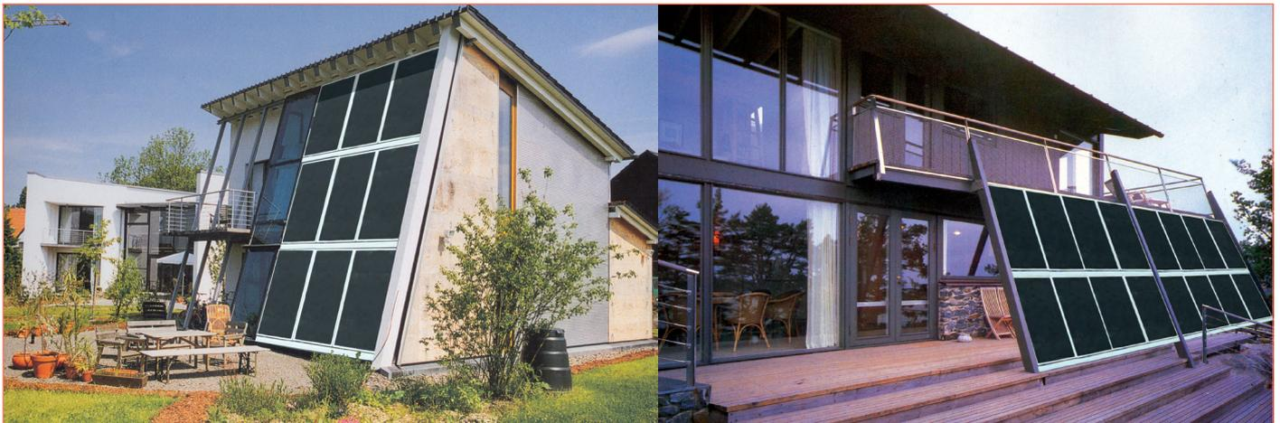
Abb. 4: LINKS: EINFAMILIENHAUS MIT FASSADENINTEGRIERTEN KOLLEKTOREN, RECHTS: NUTZUNG EINER VORHANDENEN METALLSTRUKTUR
