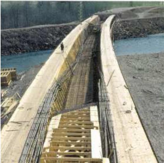
Ein Problem trat dadurch ein, dass die über 2 m hohen Stege des Brückenträgers nur 35 cm dick waren. Diese Filigranität war in konstruktiver, sowie herstellungstechnischer Sicht problematisch. Nach dem Ausschalen waren die Vorspannkabel stellenweise sichtbar.
