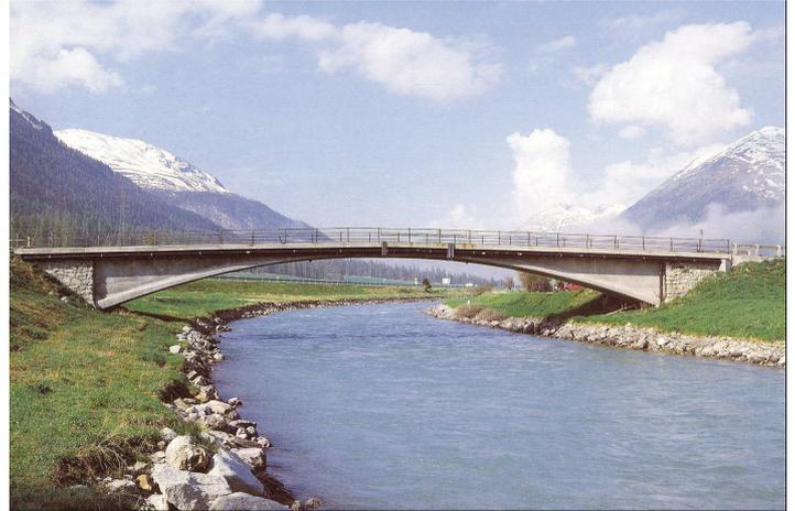
Der Hohlkasten, bestehend aus der Bogen- oder Gewölbepalte, den Seitenwänden und der Fahrbahnplatte, wird dafür ausgelegt, die Lasten als Einheit zu den Widerlagern zu tragen. Diese neue, bis dahin im Stahlbetonbau nie erprobte Idee stellte für Maillart aber auch einen Widerspruch dar.
