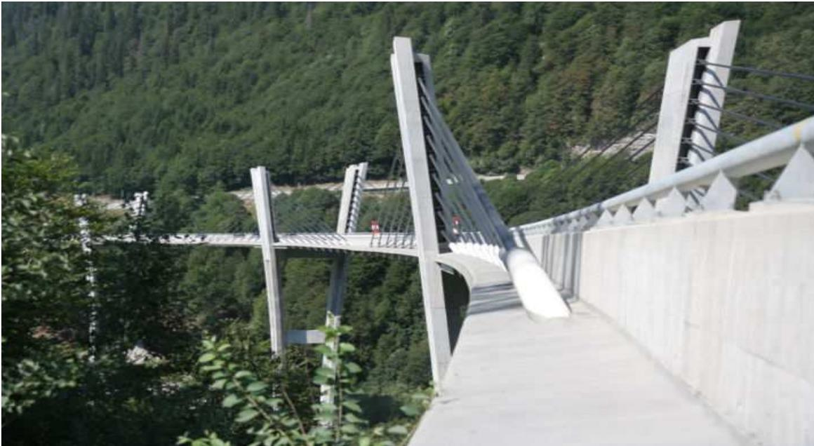
Mit dem Bau wurde im Frühling 1996 begonnen. Die Fahrbahn wurde von beiden Seiten in Freivorbau-Technik gleichzeitig Richtung Mitte geführt.
