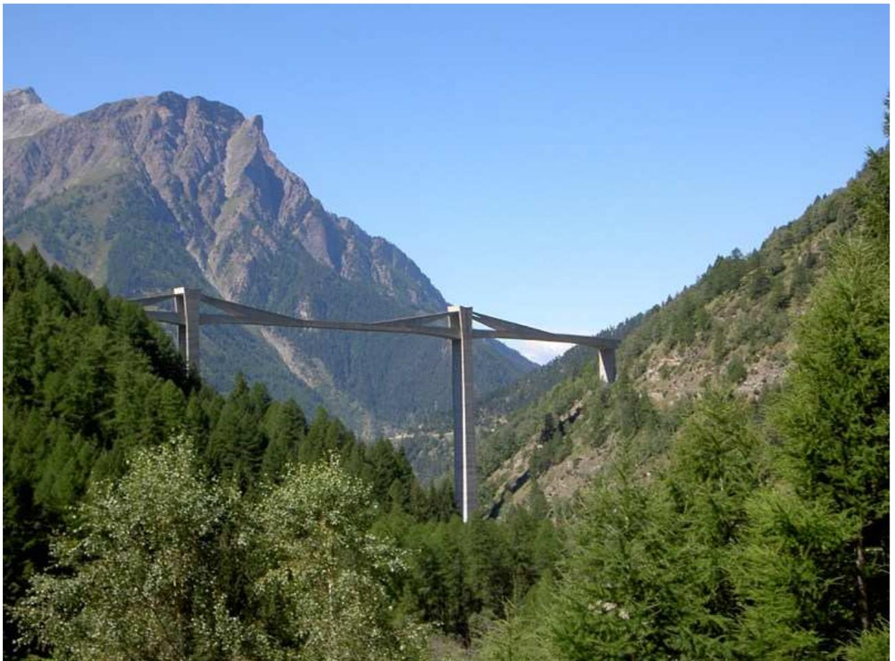
Die Ganterbrücke (im Walliserdeutsch „Ganterbrigg“ genannt), ist Bestandteil der Simplonpass-Strasse der Nationalstraße A9 und zur Zeit die Brücke mit der größten Spannweite in der Schweiz. Die Brücke, ungefähr 10 km südlich von Brig im Kanton Wallis liegend, überquert in 1450 m ü.NN das tiefe Tal des Flusses Ganter in einem S-Bogen.
