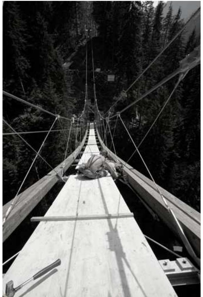
Eichenschifthölzer zum Masseausgleich eingesetzt worden. Die horizontalen Auflagerreaktionen werden über den mit dem Widerlager verschraubten Stahl-Querträger in die Fundamente geleitet.
