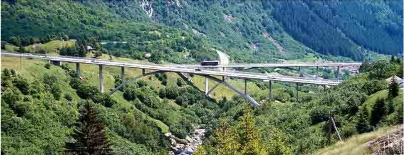
Die Straßenbrücken mit ihren massiven Bögen sind in unauffälliger Weise polygonal geformt. Die Abstände der schmalen Querwände bleiben am Hang gleich groß, bis das sehr kleine Widerlager erreicht ist. Die sehr starke Auflösung der Brücke sorgt dafür, dass die Bauwerke das Landschaftsbild nicht zerstören.
