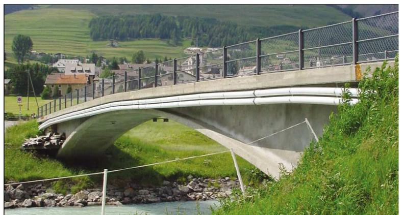
spiegeln diese bei den römischen Bogen notwendigen Seitenwände wider. Andere optische Merkmale der Zuozbrücke charakterisieren Maillarts frühes unabhängiges Arbeiten und zeigen bereits die Probleme auf, die er schließlich löste.
