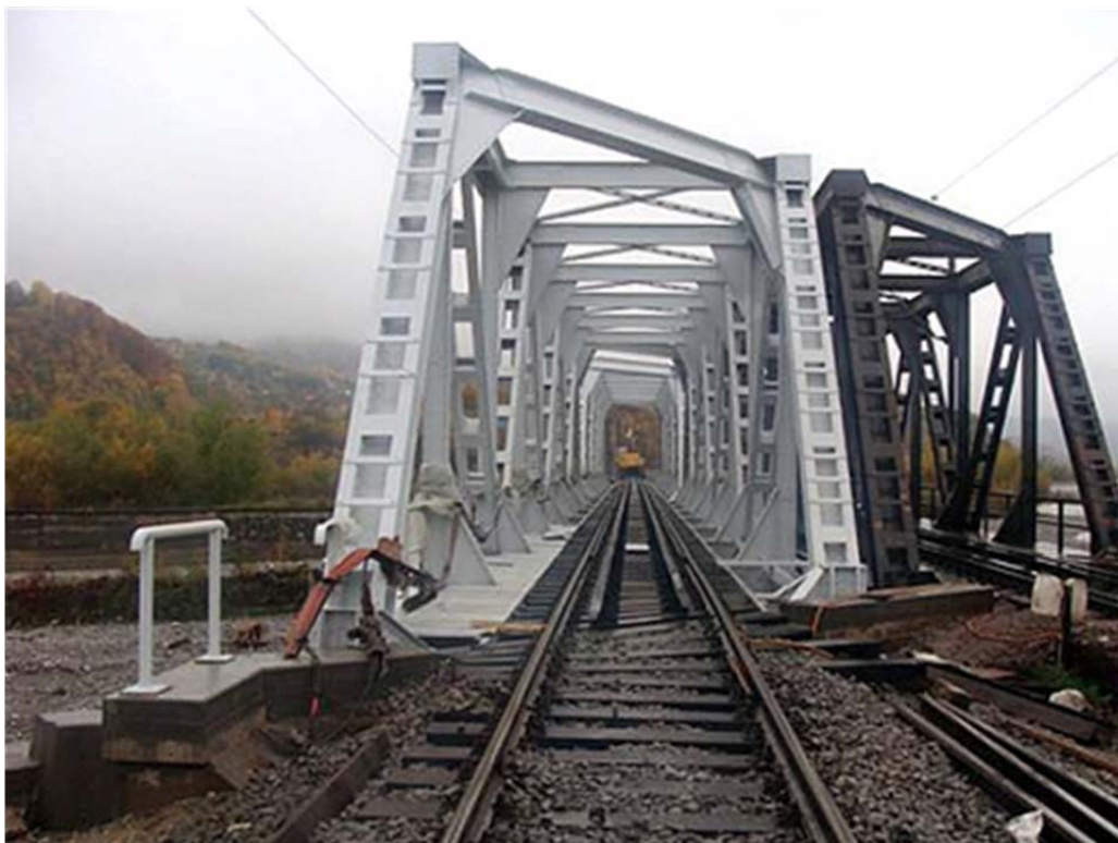
Bild 1: Fachwerkbrücke auf der Strecke (Foto: Bilfinger-Berger)
