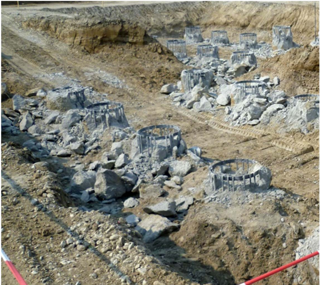
Bild 1: Gekürzte Bohrpfähle zweier leicht versetzter Fundamente (Foto: Marisa Bauer)
