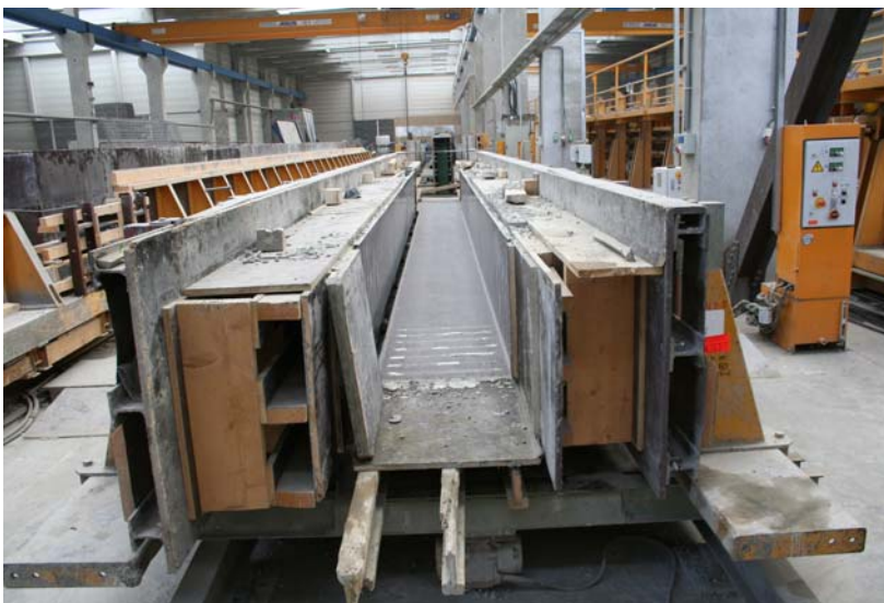
Bild 6: Bewehrung (Foto: Harun Sirkeoglu)
