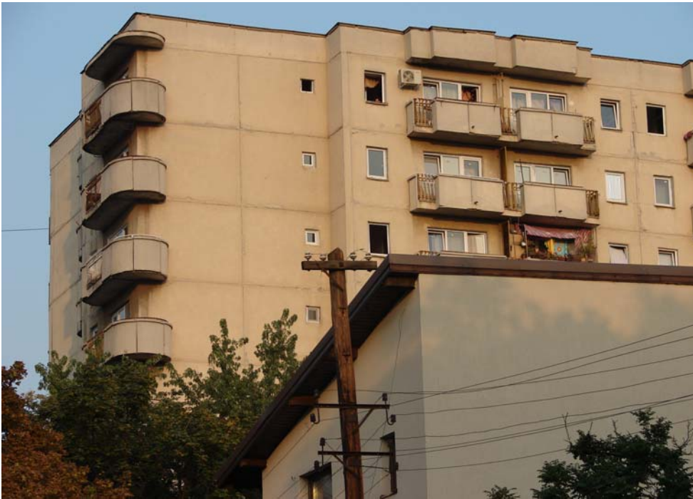
Bild 3: Plattenbau (Foto Andreas Manger)
