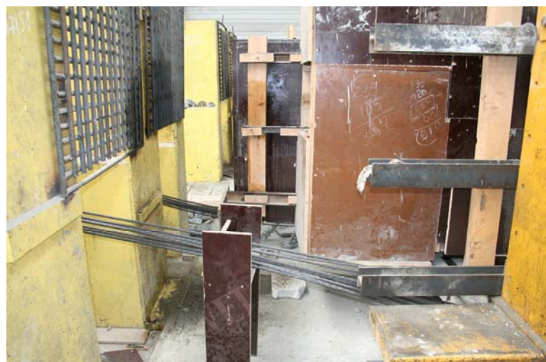
Bild 4: Bewehrung (Foto: Harun Sirkeoglu)
