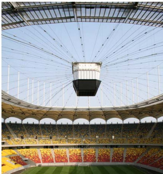
Bild 4: Dach (Foto: Harun Sirkeoglu)
