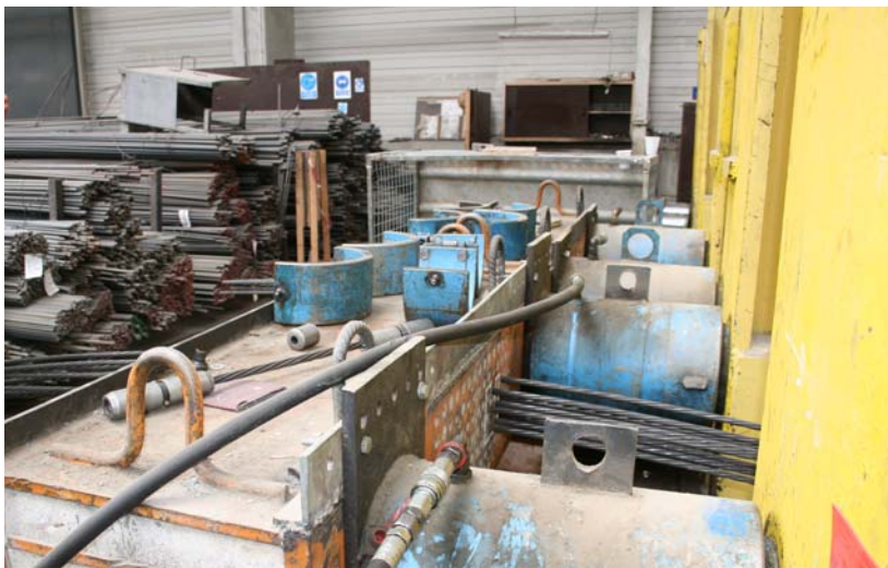
Bild 5: Widerlager der Vorspannstähle (Foto: H. Sirkeoglu)
