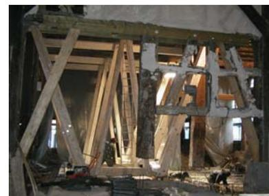
Abweichend von einer feuerbeständigen Konstruktion (F 90) wurde von einem Ingenieurbüro für Statik und Baukonstruktion<sup>2</sup> ermittelt, dass die Deckenbalken einschließlich der Unterzüge im EG und OG als hochfeuerhemmend (F 60-B) eingestuft werden können.
