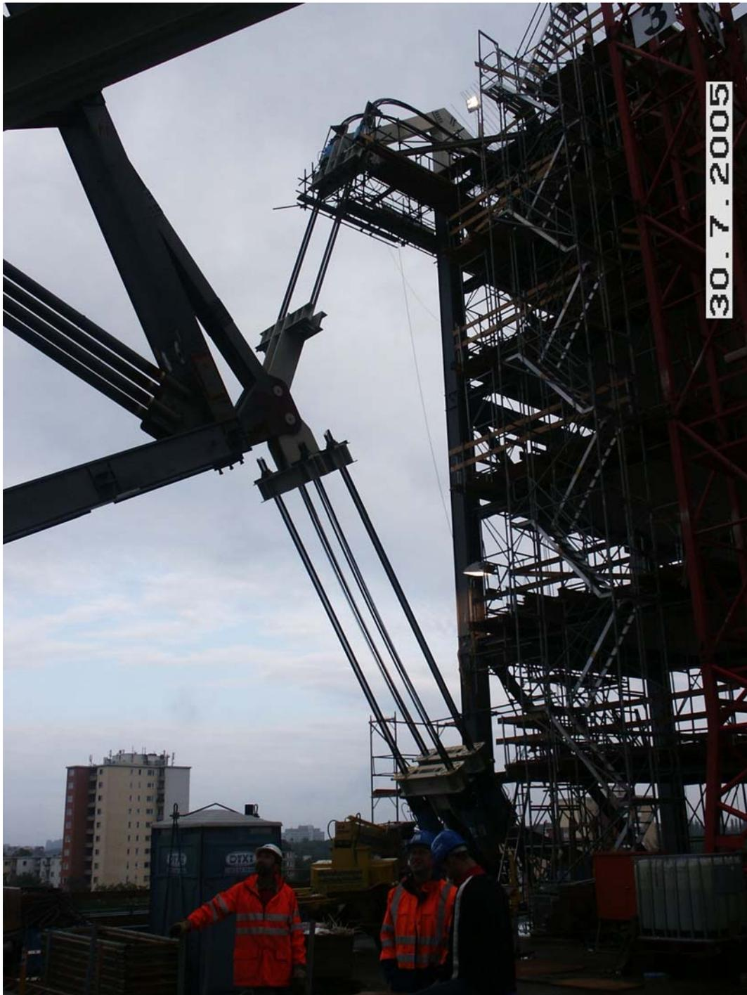
Bild 14: Hub- und Absenkvorrichtung unter Vorspannung
