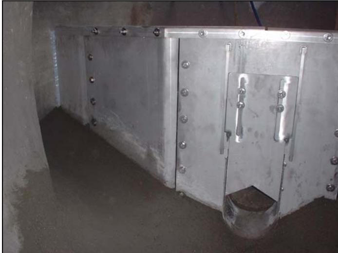
Bild 9: HydrOstyx®-Abflussbremse® in Stockach
