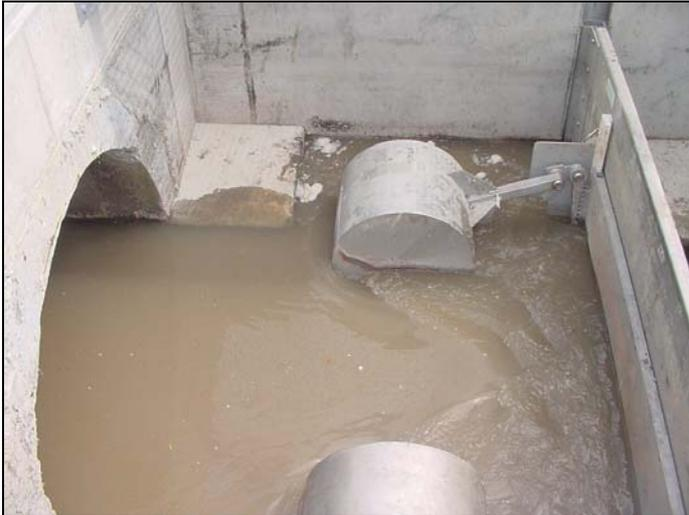
Drei dieser HydrOstyx®-Abflussbremsen® steuern die Aktivierung und Speicherraumbewirtschaftung der Speicherkaskade. Sie wirkt wie ein Fangbecken im Hauptschluss und ist aktiv bevor es zur Entlastung in das im Nebenschluss befindliche Durchlaufbecken kommt.
