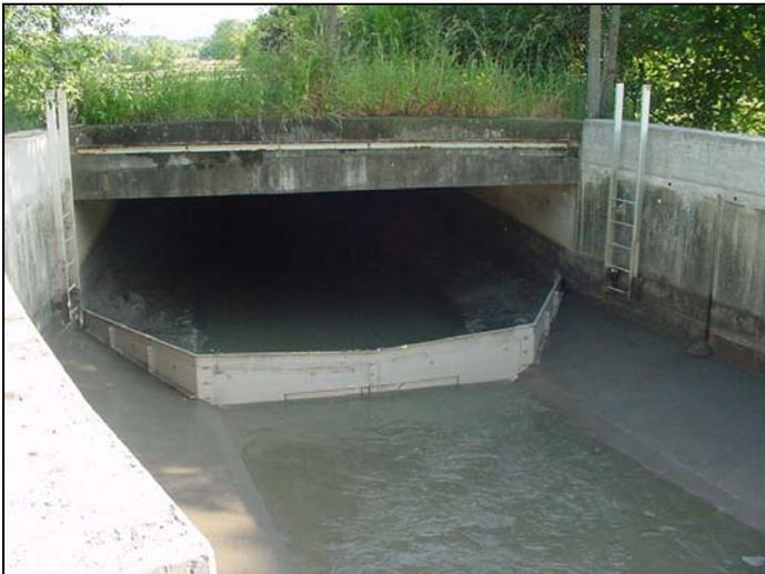
Der dargestellte, mit HydrOstyx®-Abflussbremsen® ohne Grundablass-Regler aktivierte, Retentionsspeicher beinhaltet ca. 1.000 m<sup>3</sup> anrechenbares Volumen zur Mischwasserbehandlung. Er ist ein wichtiger Teil des Verbundbeckensystems und trägt maßgebend zur Reduktion von Frachten im Entlastungsfall bei.
