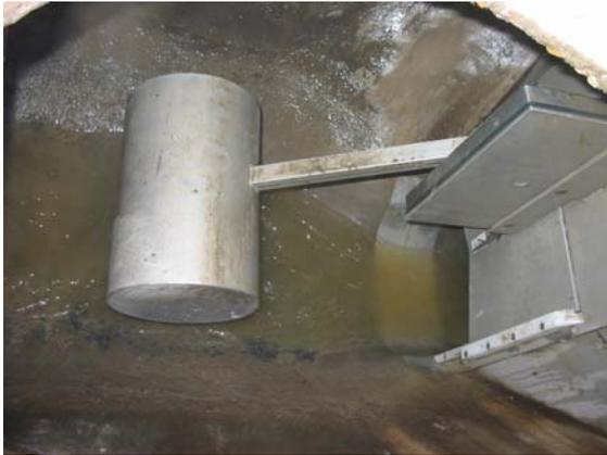
Bild 18: HydrOstyx®-Abflussbremse®
