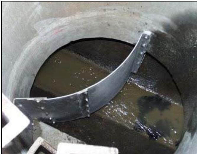
Bild 8: Vorhandener Schacht mit HydrOstyx®-Abflussbremse® in Stockach
