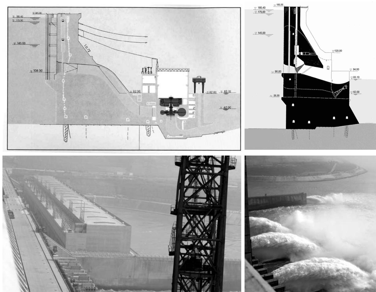
Bild 5: Schnitte und Fotos der UW-Seite von Krafthaus (links) und HW-Entlastung (rechts) des Drei-Schluchten-Damms
