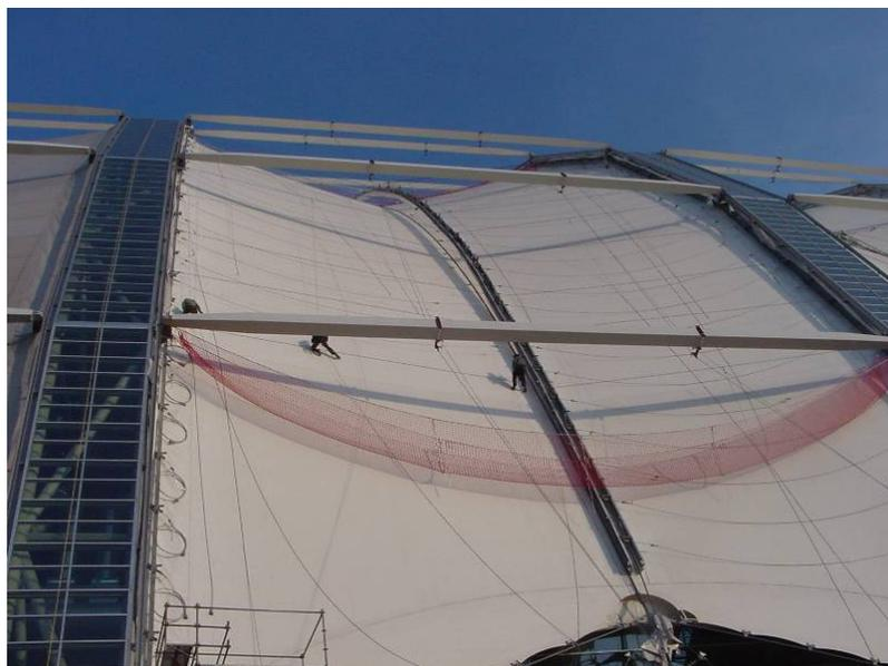
Am First beginnend werden die einzelnen Kissen auf der unteren parallelen Seilschar ausgebreitet und umlaufend angeschlossen.
