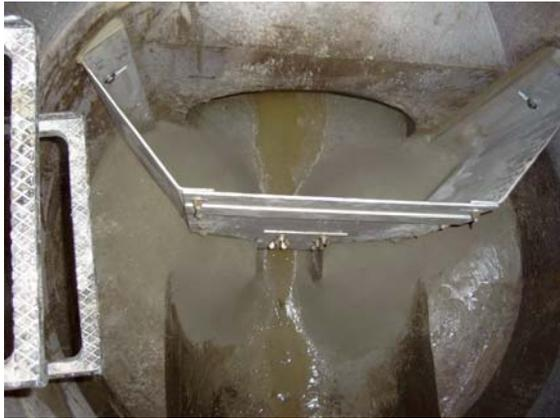
Bild 23: HydrOstyx®-Abflussbremse®
