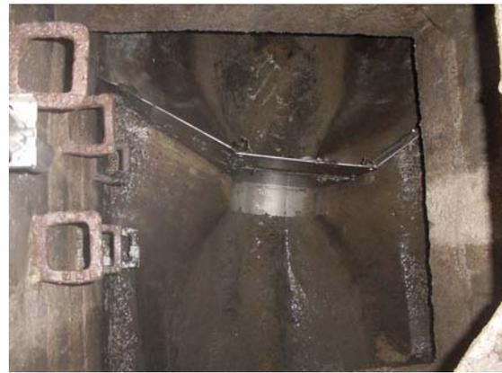
Bild 19: HydrOstyx®-Abflussbremse®
