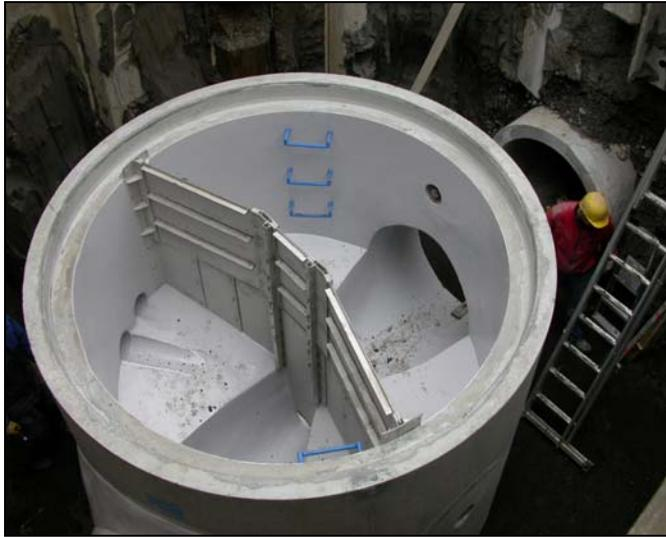
Bild 7: Fertigteilschacht mit eingebauter HydrOstyx®-Abflussbremse® in Götzis, Österreich
