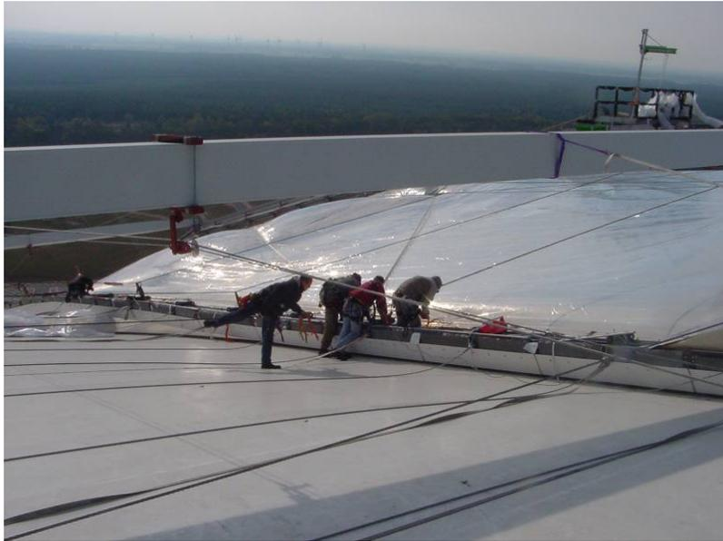
Anschließend wird das obere Seilnetz aufgelegt, und das Kissen mit einem reduzierten Stützdruck aufgeblasen.
