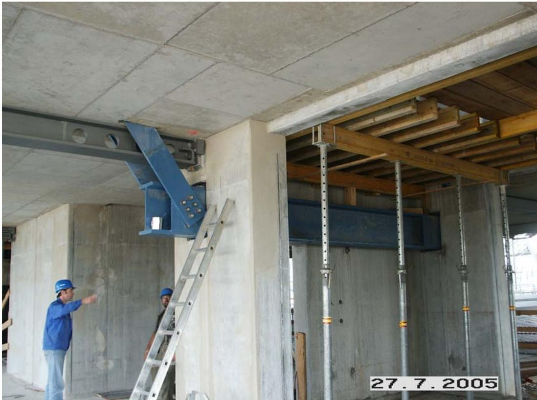
Bild 16: Rückverankerung der Zugkräfte im Kern
