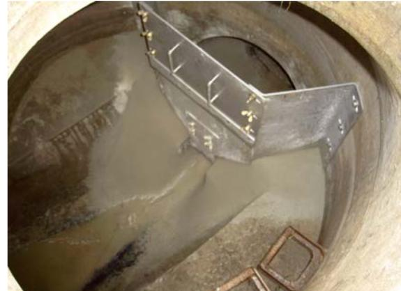
Bild 24: HydrOstyx®-Abflussbremse®
