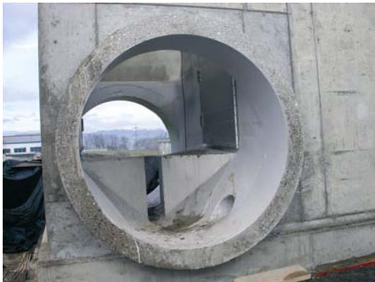
Bild 29: Betonfertigschacht mit geöffneter HydrOstyx<sup>®</sup>-Schwingbremse<sup>®</sup>
