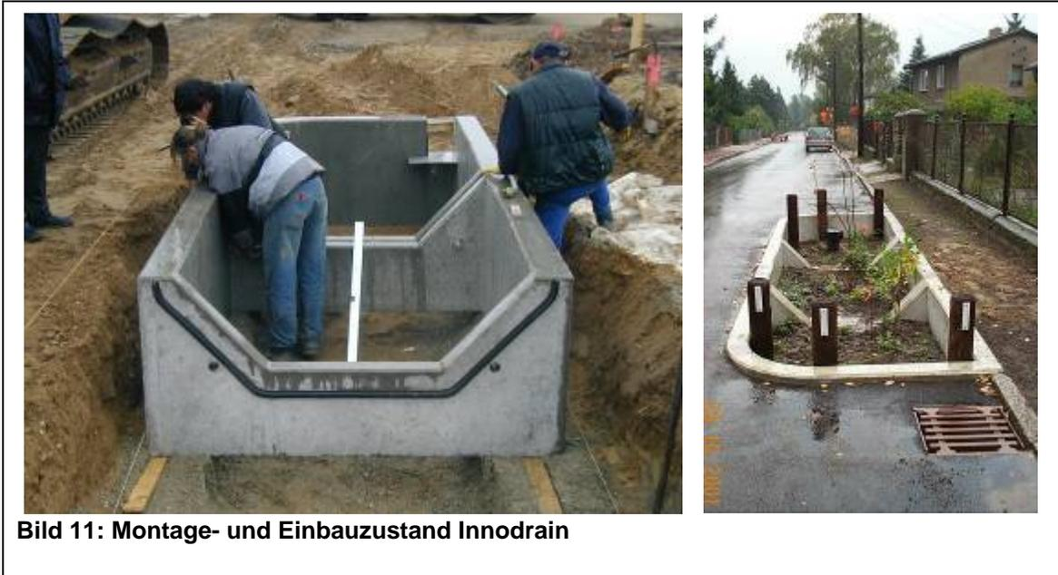
**Bild 11: Montage- und Einbauzustand Innodrain**
