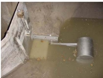
Bild 20: HydrOstyx®-Abflussbremse®
