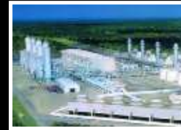
47. PLANTA DE NITRÓGENO CANTARELL
