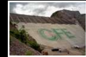
60. HIDROELECTRICA EL CAJÓN
