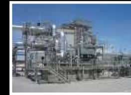
55. REGASIFICADORA LNG ALTAMIRA
