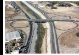
20. CANALIZACION RIO TIJUANA
