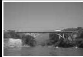
6. PUENTE BELISARIO DOMINGUEZ
