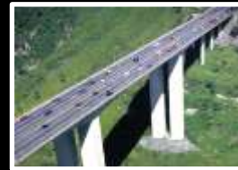
19. PUENTE EL INCIENSO GUATEMALA
